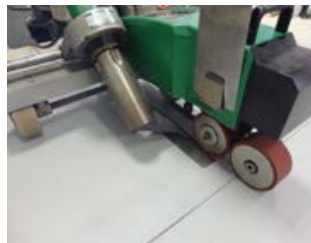
Рисунок 5.16. Очистка края полотна полимерной мембраны от флиса для сварки с соседним рулоном внахлёт
